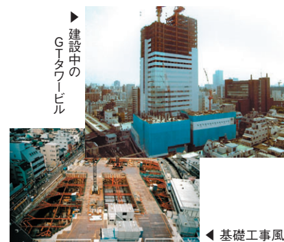
基礎工事風景
