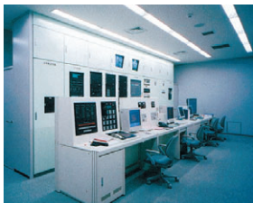
▲中央監視設備
