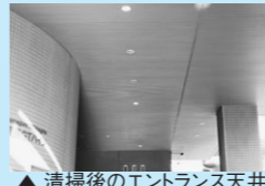
▲清掃後のエントランス天井
